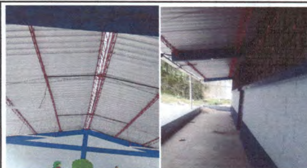
Foto 4: Estructura de soporte de metal en módulos de aulas interno y externos.
