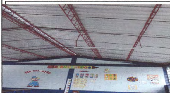
Foto 5: Sustitución de lámparas módulos de aulas.
