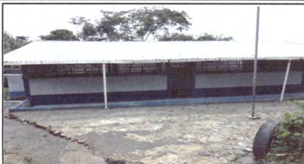
Foto 1: Sustitución de lámina troquelada aluzin calibre 26.
