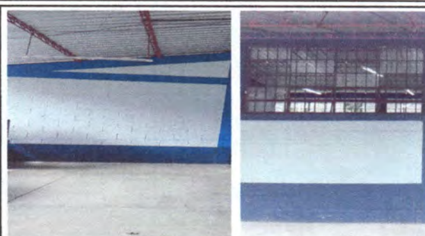
Foto 2: Pintura en muros interiores y exteriores en módulos de aulas.
